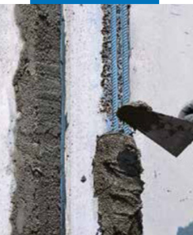
Нанесение раствора мастерком
